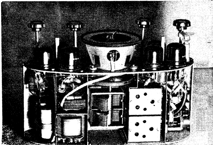
Bild 4. Chassis des Autosuperhets der Fa. Fahnenschreiber
